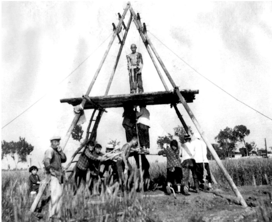
通过调查分析,土壤专家熊毅在封丘尝试打井治理土壤盐碱。图为盛水源村打井的情景。本版老照片均为翻拍资料照片
