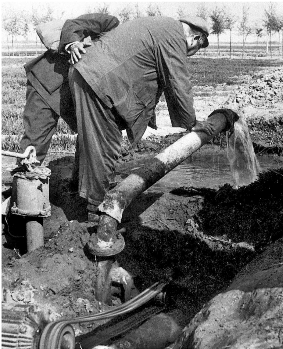
1965年，土壤专家熊毅(右一)在封丘尝试打井治理土壤盐碱。图为熊毅在机井旁观察抽水试验。翻拍资料照片
